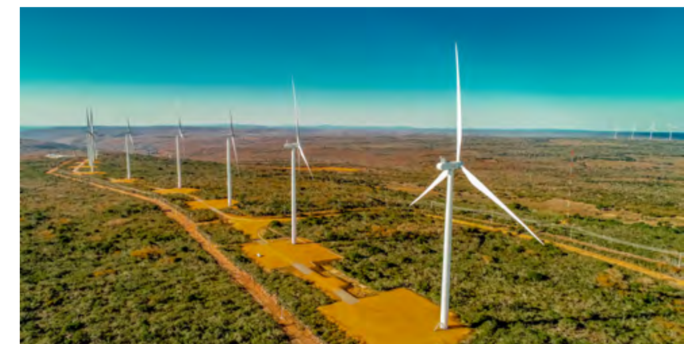
Usinas Fotovoltaicas Pirapora e Parque Eólico Ventos da Bahia.
